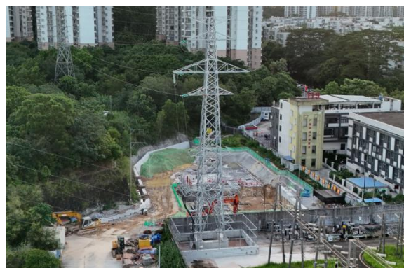
110kV 祈福站内新建电缆终端塔
