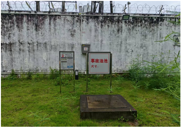
站内事故油池
