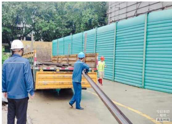
施工临时围挡
