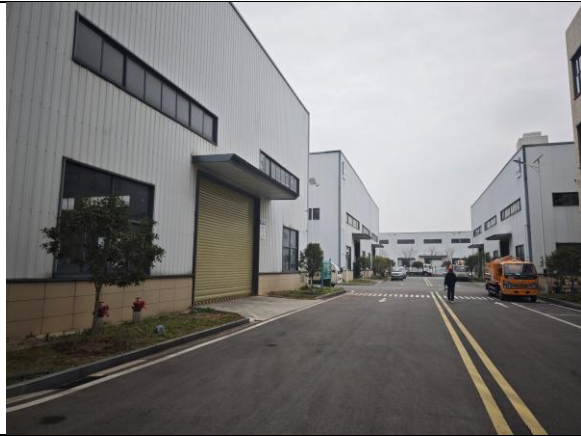
探伤室所在车间外西侧
