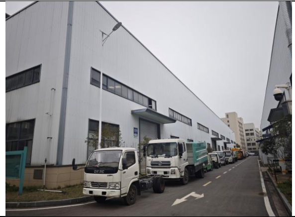
探伤室所在车间外南侧
