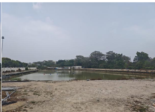
拟建储能电站东北侧
