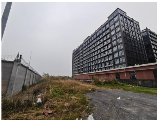
220kV 镜湖变电站进线侧外环境
