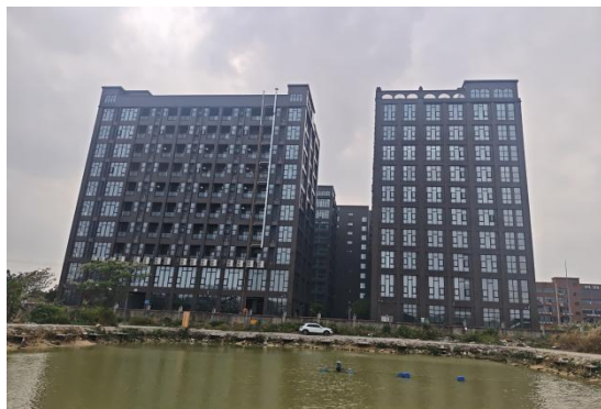
拟建储能电站西南侧
