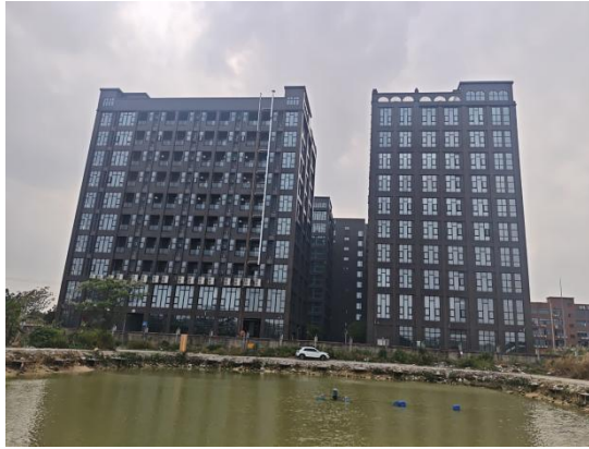
拟建储能电站西南侧
