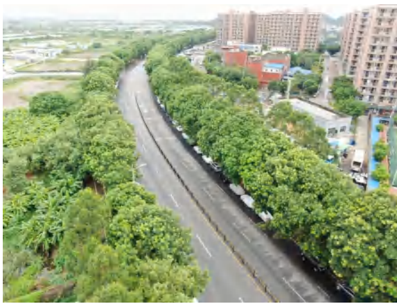
110kV 鳧洲~中船 II 双回电缆线路沿线 (启航路)
