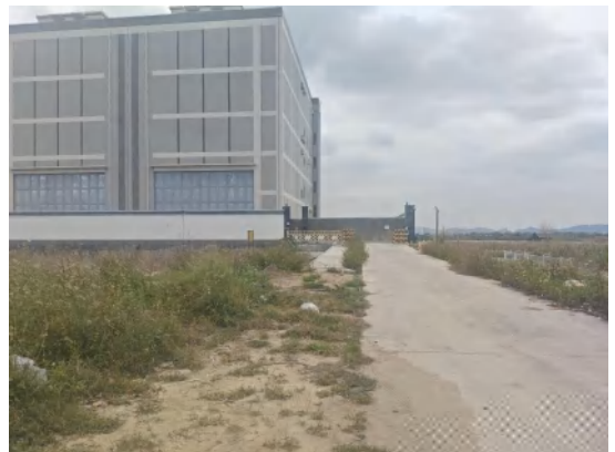
新建 110kV 皂洲~中船 II 双回电缆线路 沿线（220kV 皂洲站侧）
