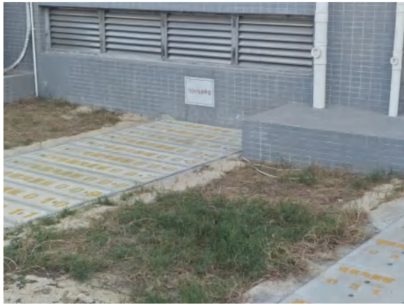
110kV 皂洲~中船 II 甲线出线
