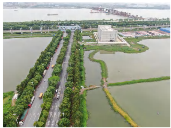
110kV 鳧洲~中船 II 双回电缆线路沿线 (万龙东路)
