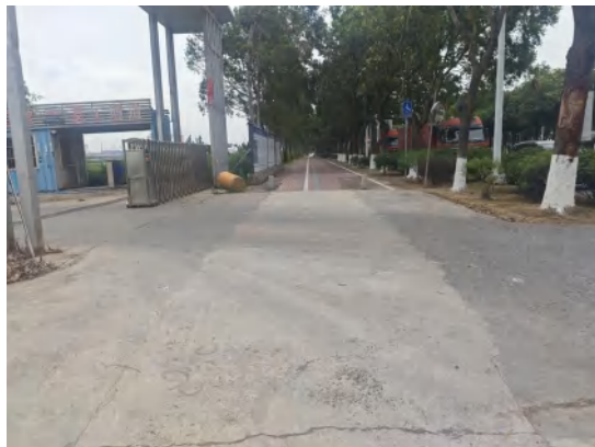
新建 110kV 皂洲~中船 II 双回电缆线路沿 线（万龙东路）
