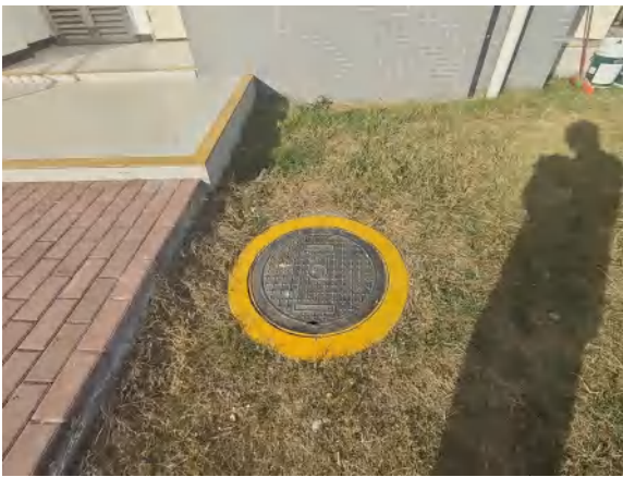
站内污水井盖
