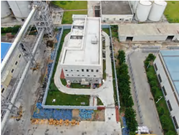
变电站现状航拍照片
