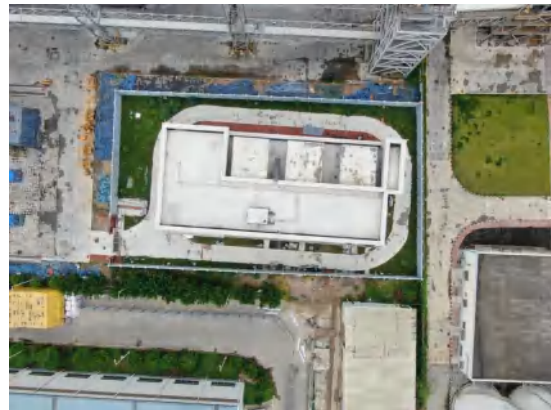
变电站现状航拍照片
