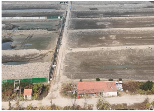
拟建启圣（沂北）220kV 变电站站址 东侧
