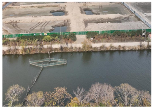
拟建启圣（沂北）220kV 变电站站址 南侧
