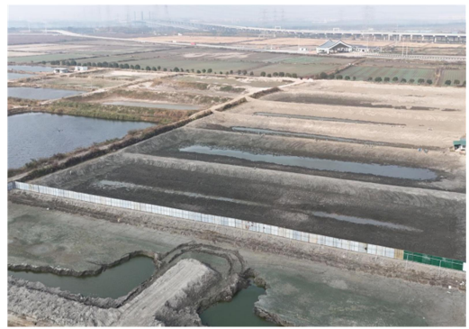
拟建启圣（沂北）220kV 变电站站址 北侧
