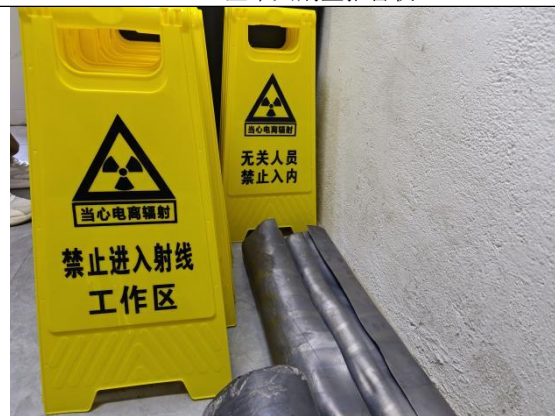
警示标识、警告标语 （“禁止进入射线工作区”“无关人员禁止入内”）
