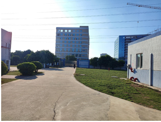
220kV 空港变电站进站道路
