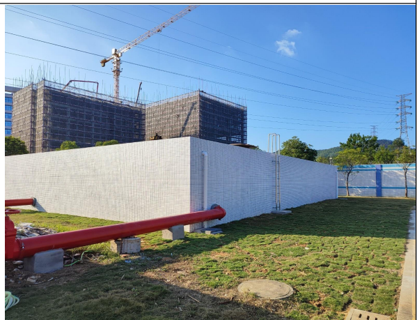
本期新建消防水池
