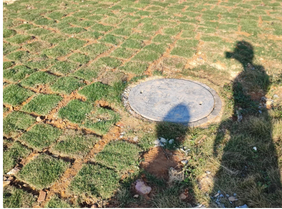
220kV 空港变电站站内污水井
