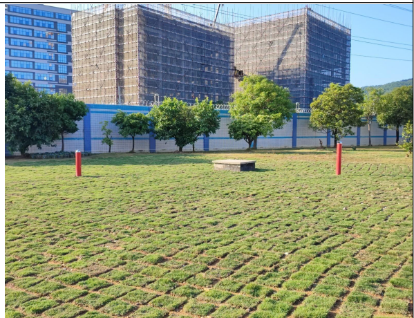
本期新建事故油池
