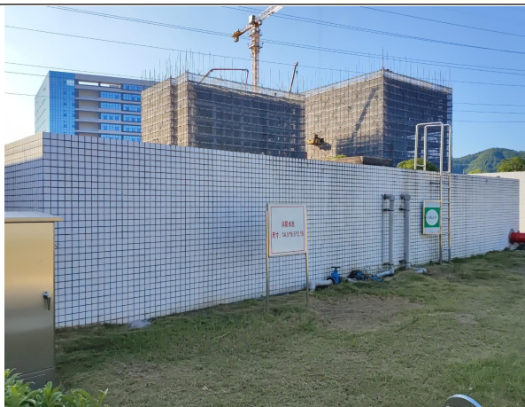
前期已建消防水池
