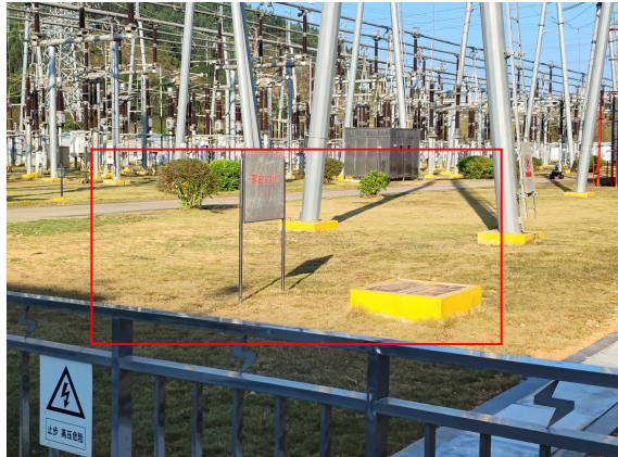
220kV 空港变电站前期已建事故油池
