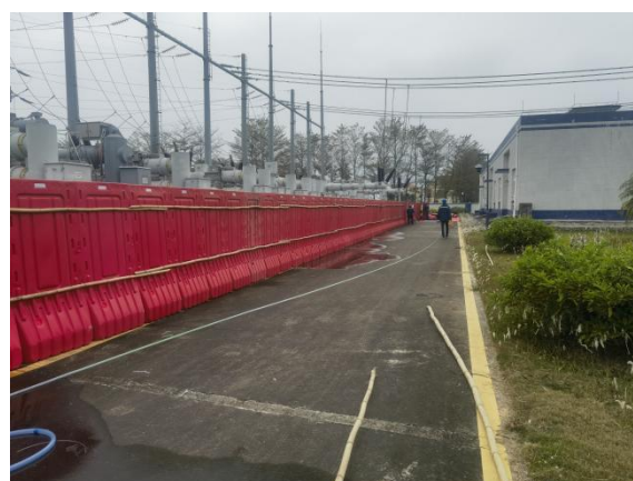
施工场地洒水
