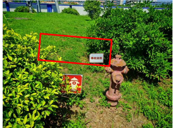
新建事故油池
