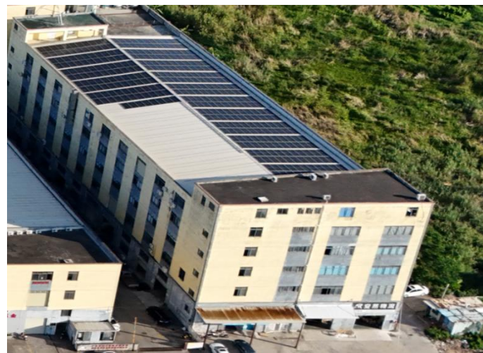
中山市正建消防工程有限公司
