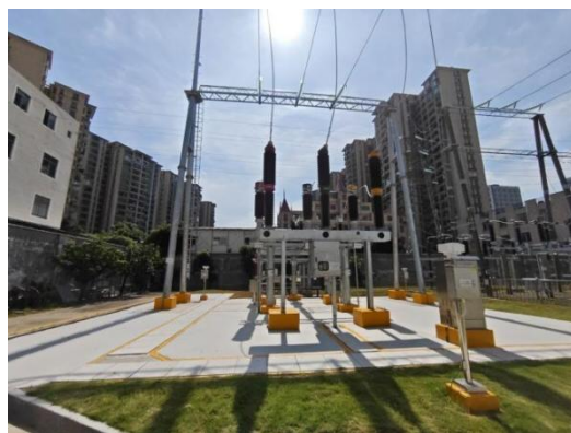
3#出线构架外绿化情况
