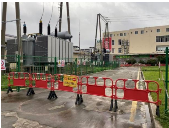
路面洒水降尘
