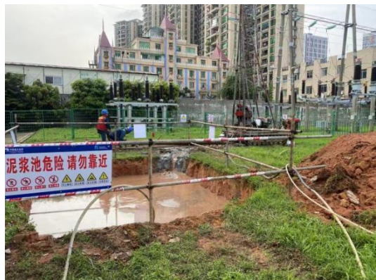
施工临时沉淀池
