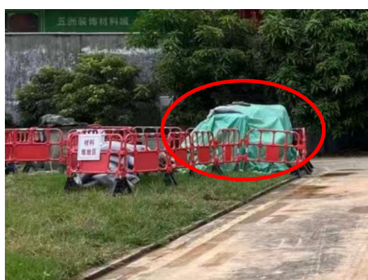
临时材料苫盖
