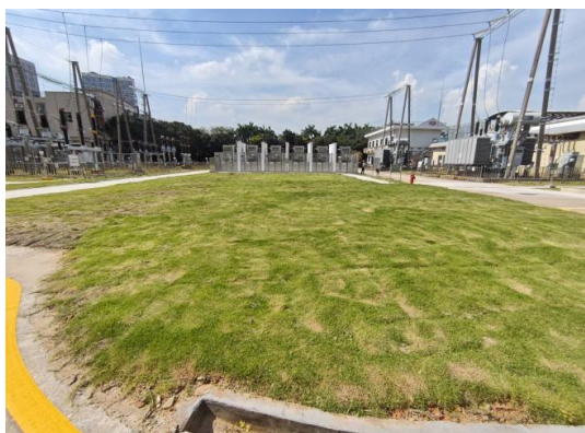
新建电容器组成套装置旁绿化情况
