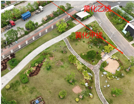
输电线路沿线绿化（广州市净水有限公司大沙地分公司内部）
