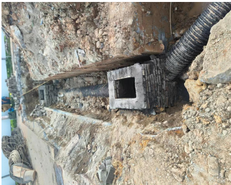
塔基开挖过程修建排水沟
