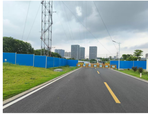
施工期间利用现有道路作为施工便道
