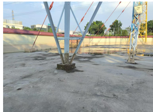
塔基下方地面硬化
