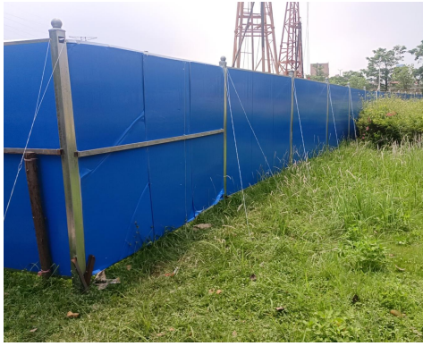
塔基施工过程临时围挡
