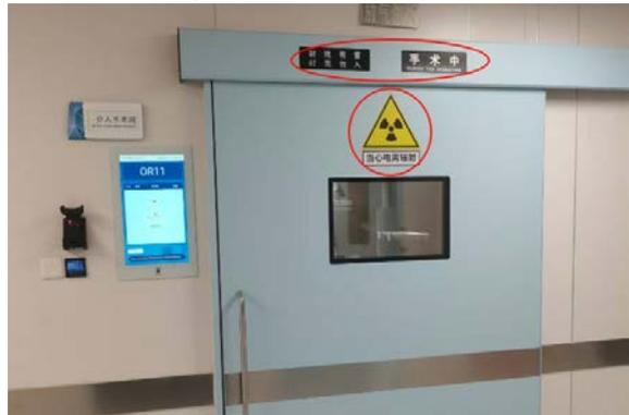
北楼 4 层 DSA 机房患者进出防护门工作状态指示灯、电离辐射警告标志及中文说明
