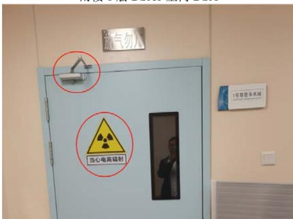
南楼 6 层 DSA1 室医护进出防护门自动闭门装置、电离辐射警告标志及中文说明
