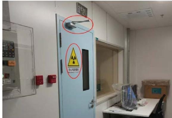
北楼4层 DSA 机房医护进出防护门自动闭门装置电离辐射警告标志及中文说明
