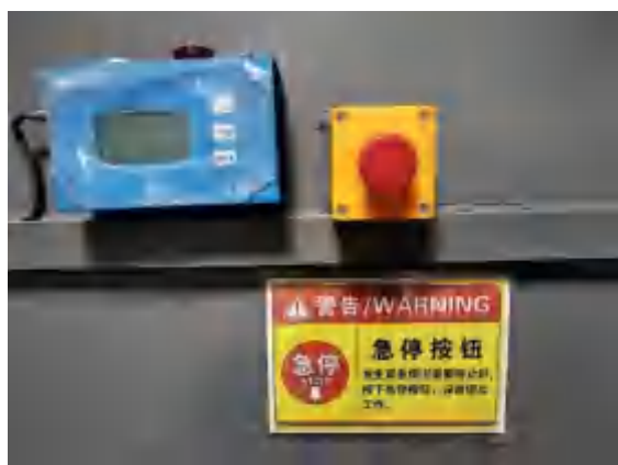
急停按钮、固定式辐射报警仪探头
