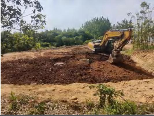
塔基基础施工完成后开挖土方回填及地面平整
