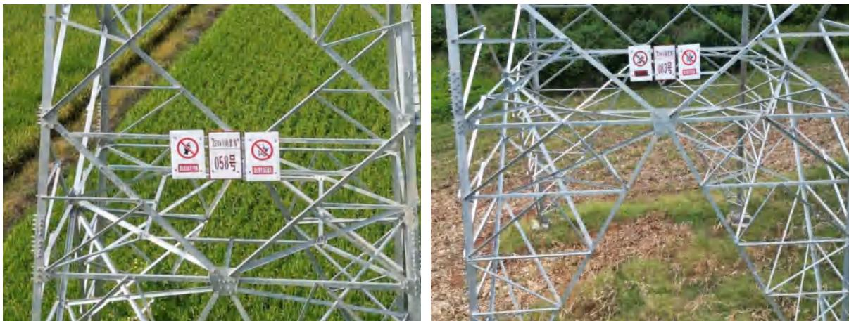
图8-3 本项目220kV尚官线杆塔警示和防护指示标志
