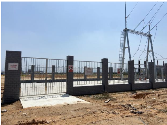
新建 110kV 电缆终端场
