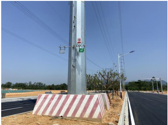
塔基下方土地平整
