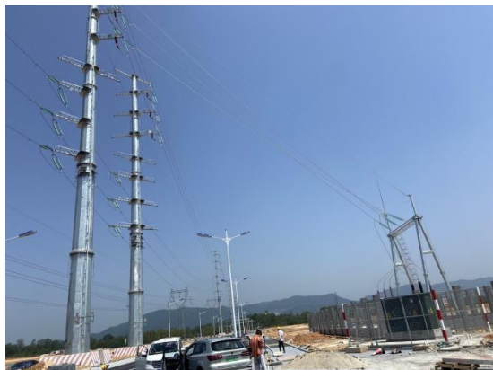
电缆终端场西侧架空线上线塔基
