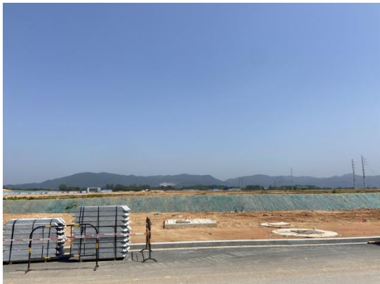
已拆除线路(110kV 从明森线原#31 塔处)
