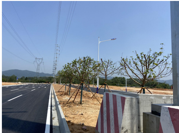
架空线路沿线植被
