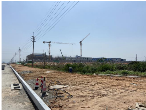
电缆沟上方土地平整
