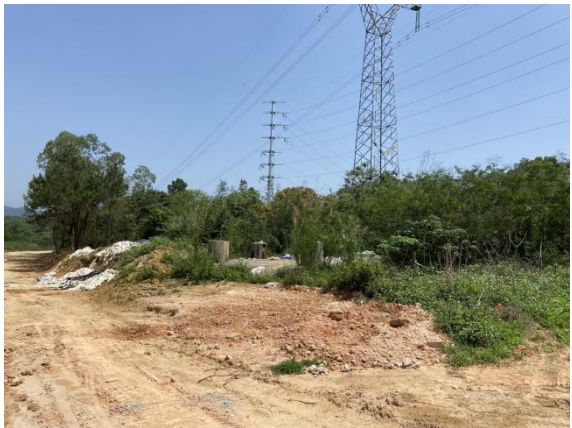
已拆除塔基周边场地清理
