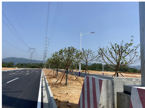
新建 110kV 架空线路
