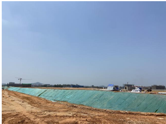
已拆除线路周边土地平整
