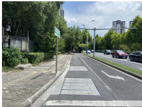
电缆沟上方道路硬化
