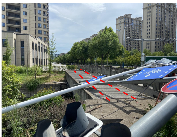
本项目电缆线路沿线
