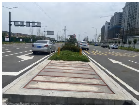
本项目电缆线路沿线
