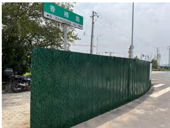
施工场地围挡
