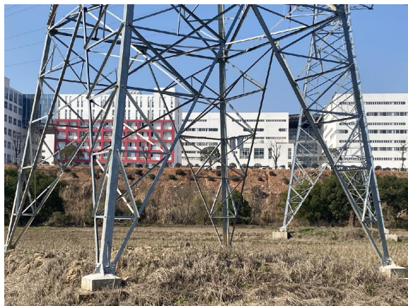
110kV 元江 1908 固废支线 #1 塔基下方复垦
