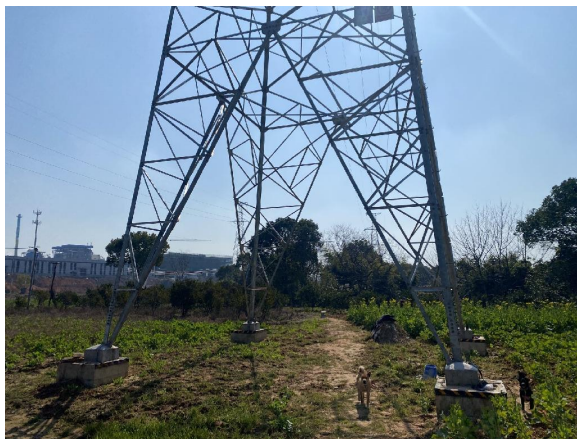
110kV 元江 1908 固废支线 #4 塔基下方绿化恢复
