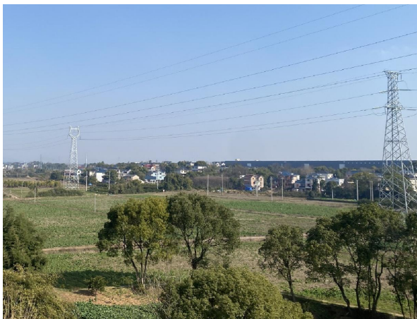
新建输电线路下方临时占地恢复
