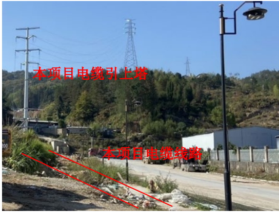
本项目电缆线路上方植被恢复
