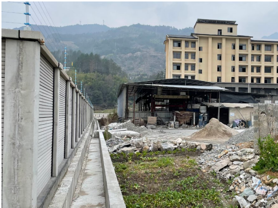
变电站东南侧外环境现场照片
