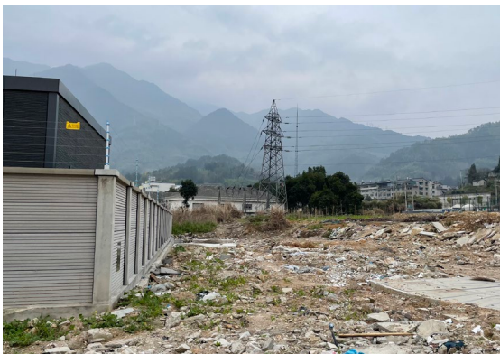
变电站西南侧外环境现场照片
