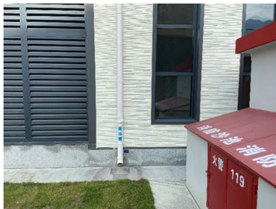
雨水排放管道
