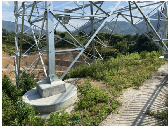
鹤溪~沙湾 110kV 线路#7 塔塔基植被恢复
