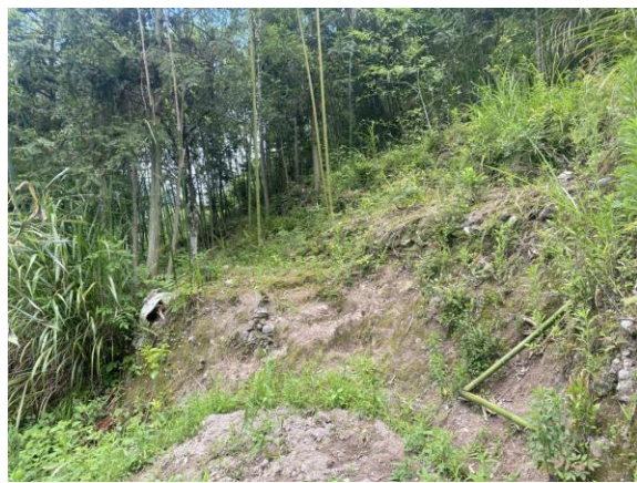
输电线路施工便道植被恢复
