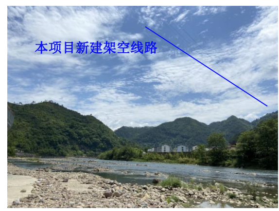
鹤溪~英川 T 接沙湾变 110kV 线路跨越小溪采用一档跨越
