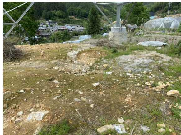
鹤溪~沙湾 110kV 线路#1 塔塔基植被恢复 (塔基下方已撒播草籽)
