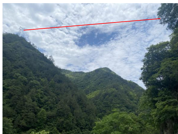
本项目架空线路沿山地走向
