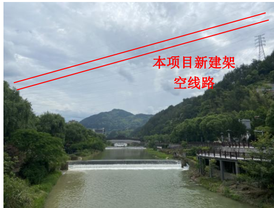
鹤溪~沙湾 110kV 架空线路跨越鹤溪
