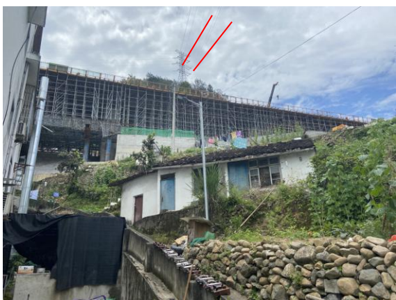
线路跨越在建景文高速
