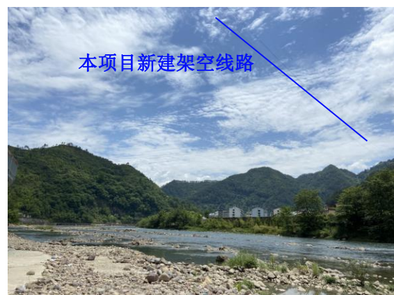
鹤溪~英川 T 接沙湾变 110 千伏线路跨越
