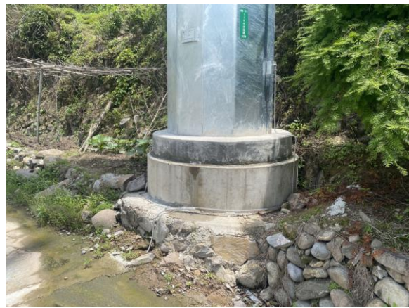
鹤溪~沙湾 110kV 线路#80 塔基固化
