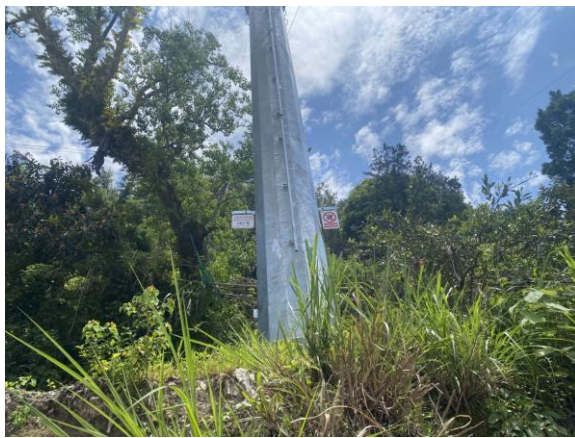
川溪 1085 沙湾 T 接线#1 塔周边植被恢复
