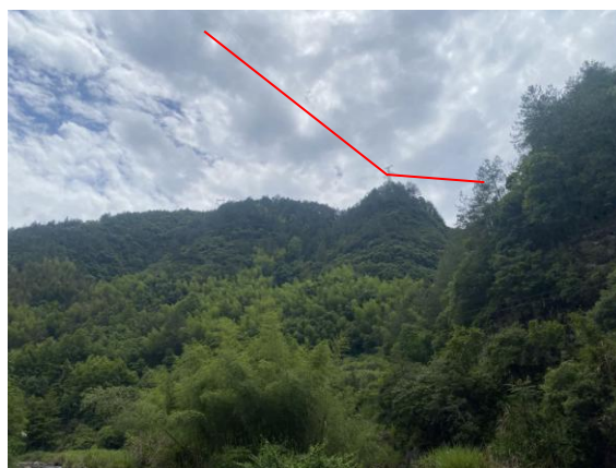
本项目架空线路沿山地走向
