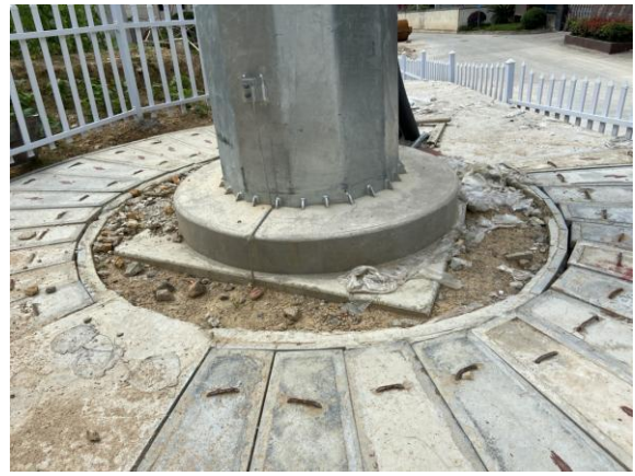
鹤溪~沙湾 110kV 线路#8 塔塔基平整固化
