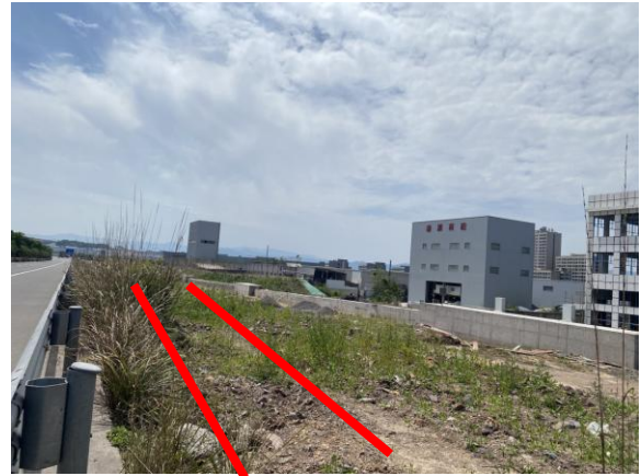
电缆线路上方植被恢复
