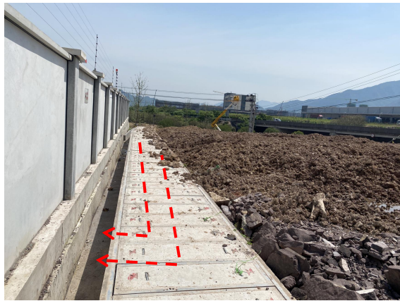
电缆线路接入下张（陶庄）110kV 变电站
