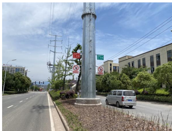
塔基下方植被恢复
