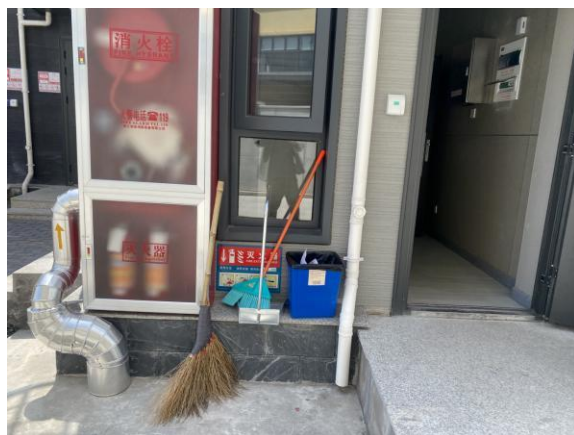
变电站内垃圾桶
