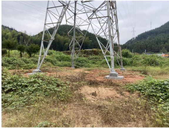
110kV 定翔 1801 线#4 塔基恢复
