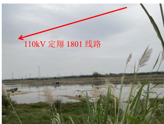
图 4-4 线路跨越常山港现场照片
