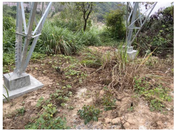
110kV 定翔 1801#20 塔基恢复
