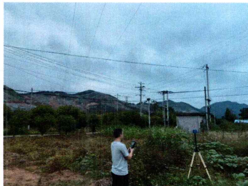
110kV 定翔 1801 单回架空线路 电磁环境断面现状检测
