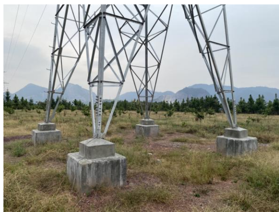
110kV 定翔 1801#16 塔基下方植被恢复
