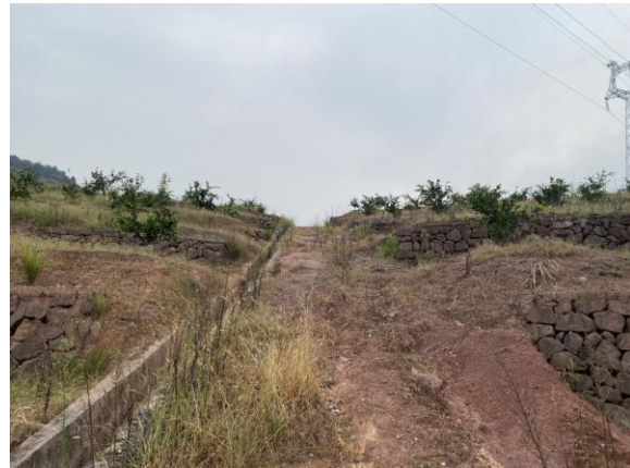
施工临时便道恢复
