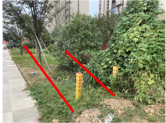
电缆线路上方植被恢复
