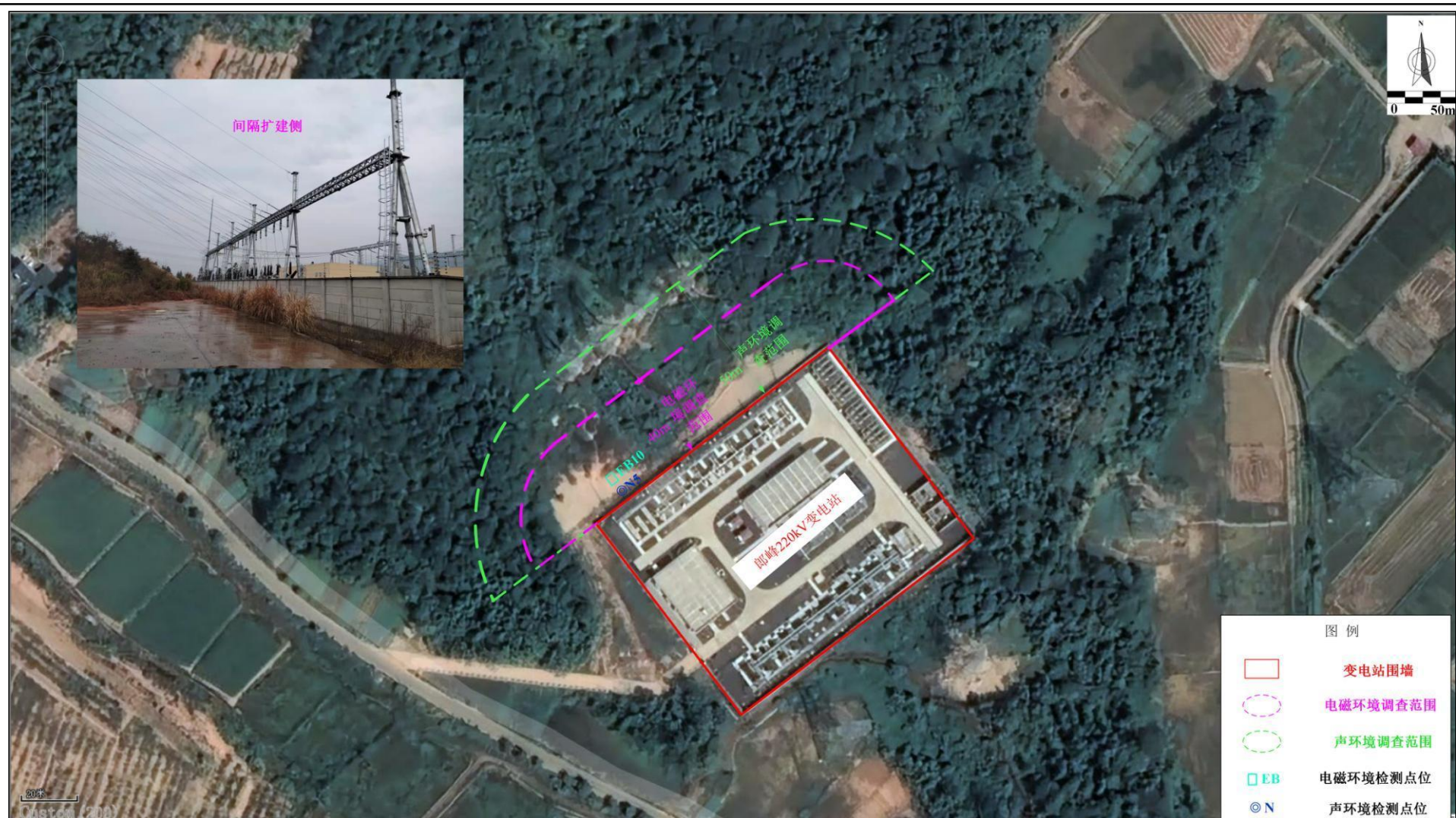
图 2-3 郎峰 220kV 变电站间隔扩建侧周边环境示意图
