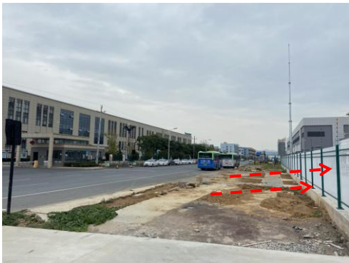
电缆线路接入山海 110kV 变电站
