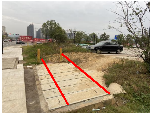
电缆线路上方植被恢复
